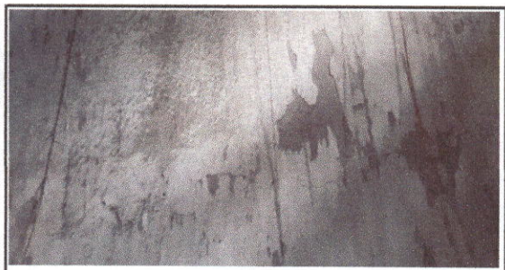
Foto 6: Pintura en muros exteriores e interiores
