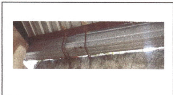
Foto 4: Sustrucción de canal de metal
